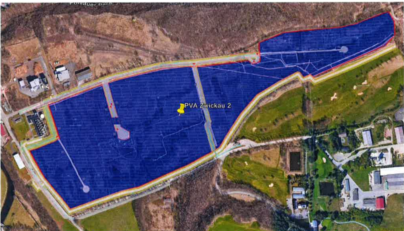
Bild 2.3: Luftbild der PV Anlage (Quelle: Google Earth / SolPEG)
