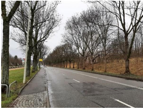
Abb. 6: Planitzer Straße, Blick Richtung Nord
