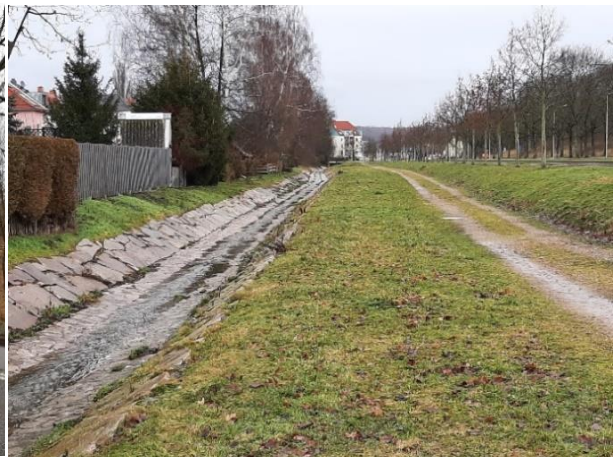
Abb. 7: Planitzbach mit begleitendem Gehweg, Blick Richtung Nord
