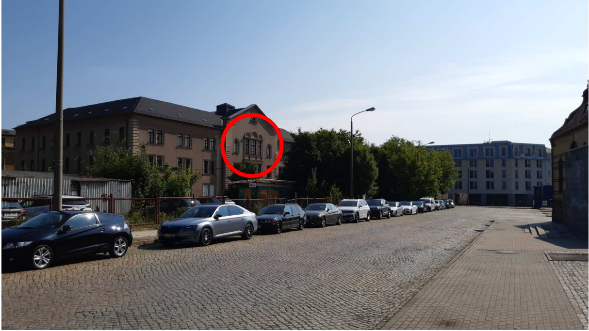
Abbildung: Immissionsort IP 6 (Bürogebäude Werdauer Straße 7)
